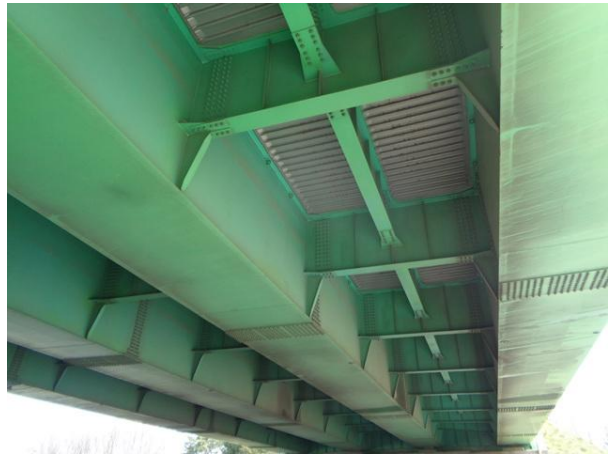
바닥판, 거더외부 전경
